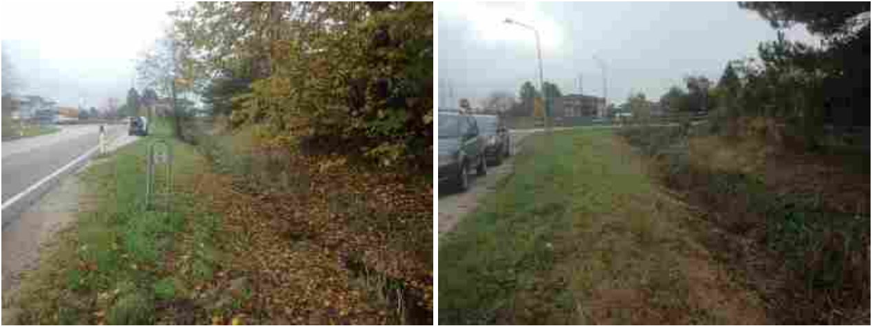
Fig. 2.14 – 2.15 - Tratto di canale in fregio alla SP16
