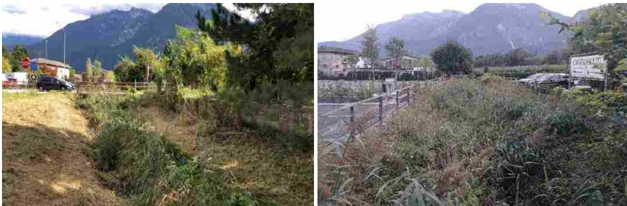
Fig. 1.5 – 1.6 – Rio Brentella nel tratto lungo la SP16 ed in corrispondenza del ponte sulla SP1 (monte e valle)
