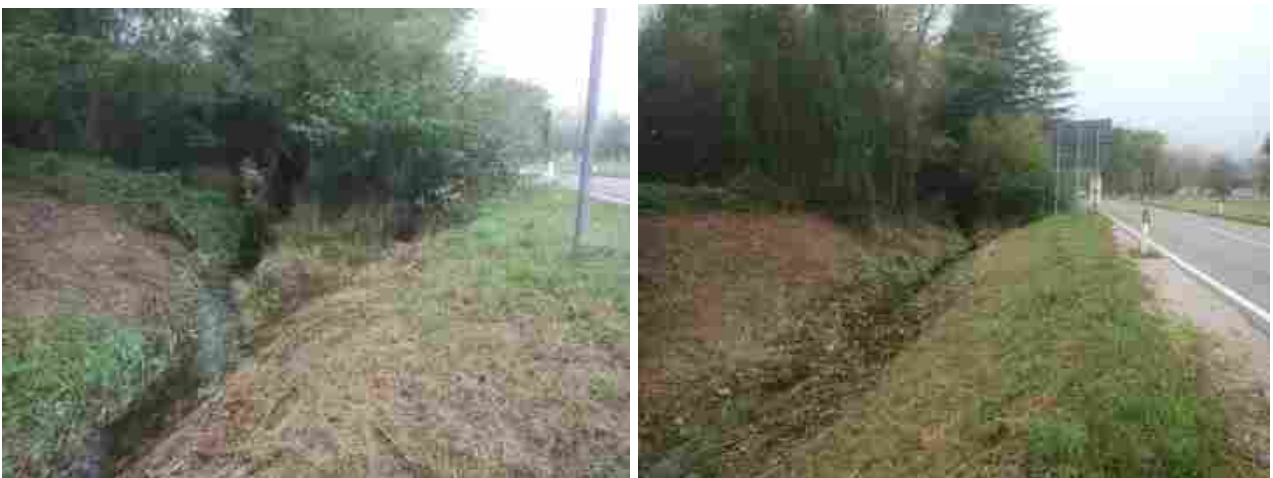
Fig. 2.12 – 2.13- Uscita dall'area del camping: il canale in cemento diventa un canale seminaturale parzialmente ostruito dalla folta vegetazione arbustiva
