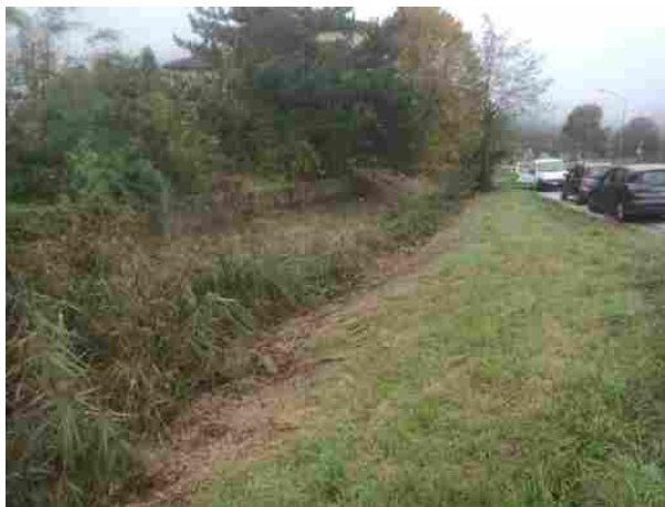
Fig. 6.2-6.4 - Vegetazione arbustiva invadente che parzializza le sezioni idrauliche. In questo tratto prevista al copertura con la nuova rotatoria.
