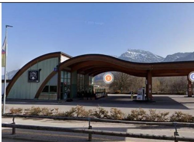
Distributore nei pressi dell'area di intervento (h 7m)
