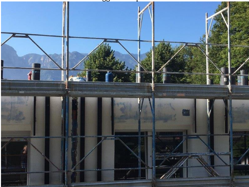
ponteggi esterni lavori
