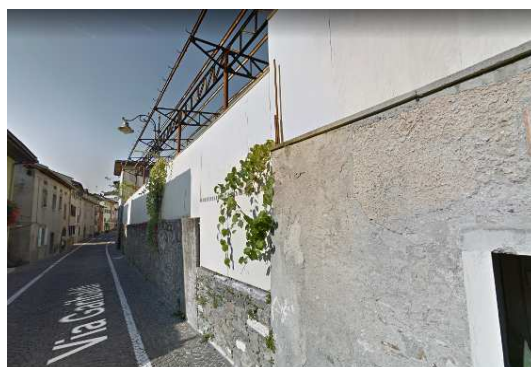
Quello che resta dell'ex "cinema all'aperto" su via Garibaldi (prospetto Sud)
