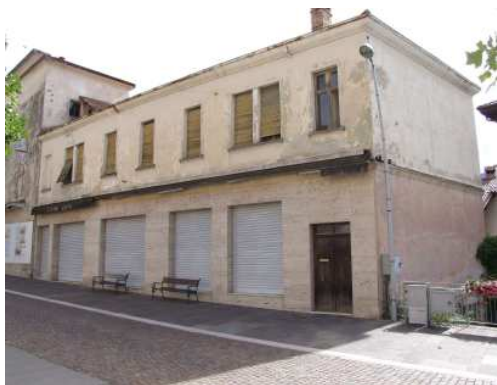
L'ex Caffè Concerto visto da via Dante Alighieri (prospetto Nord)
