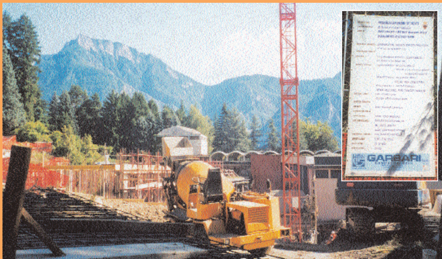
Sono ricominciati i lavori alle Terme di Viale Vittorio Emanuele e Viale Roma
