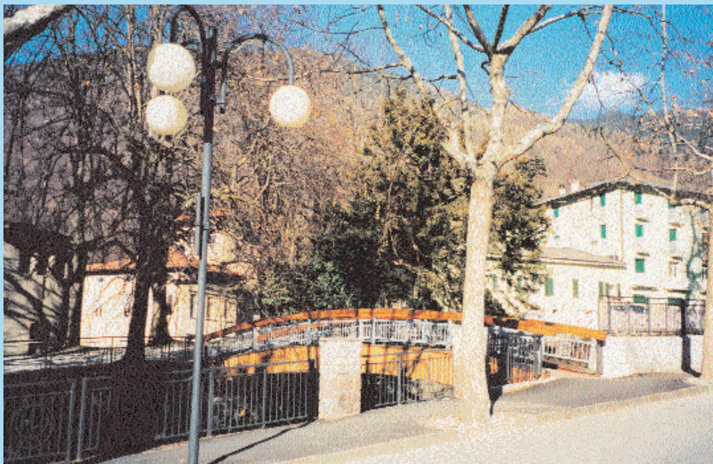
La passerella sul Rio Maggiore e le nuove ringhiere: un'intervento di arredo urbano di oltre 300 milioni di vecchie lire da parte del Comune di Levico Terme
