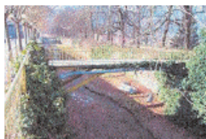
La vecchia passerella sul Rio Maggiore
