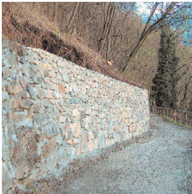
Strada Col delle Benne dopo gli interventi
