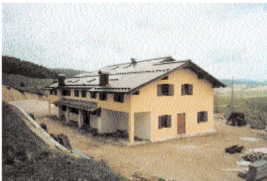
Colonia di Vezzena dopo gli interventi di ristrutturazione
