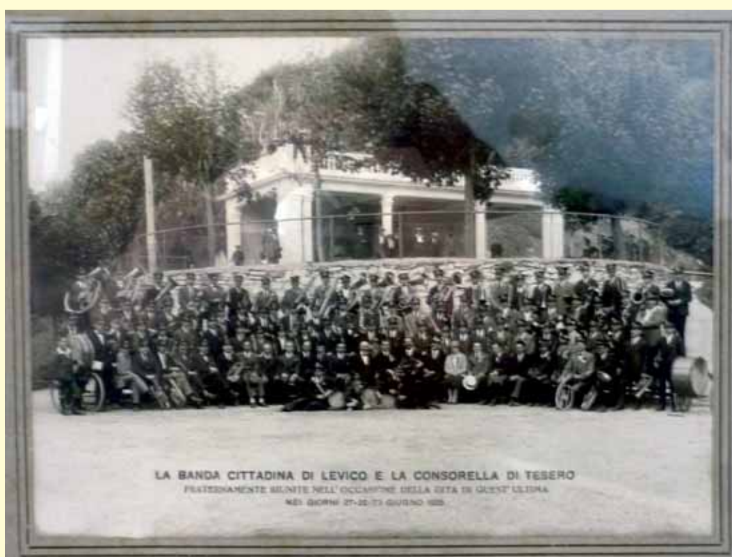
La struttura al Parco Belvedere com'era nel 1925
